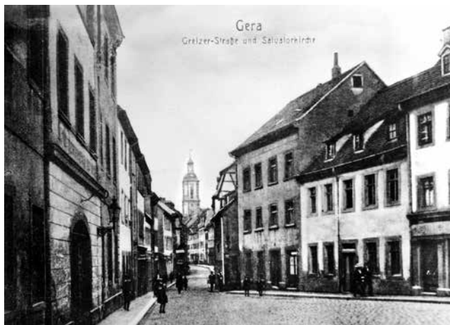
Einst standen beidseits der Greizer Gasse die Häuser der Tuchmacher.
