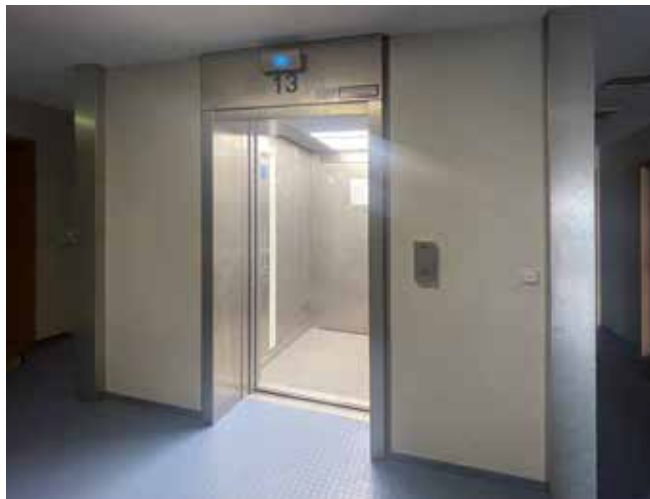
Aufzugsanlage mit neuer Beleuchtung und Leuchtdisplays
