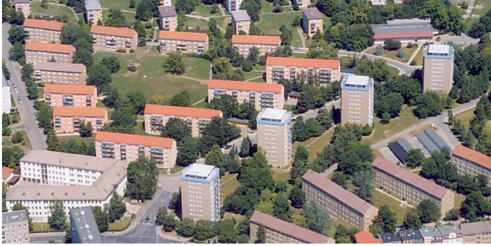
Punkthochhäuser Johannes-R.-Becher- Straße 2, 4, 8 und 12 im Denkmalensemble Bieblacher Hang
