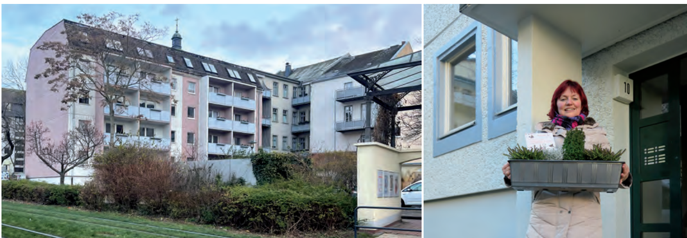
Blick zum neugestalteten Innenstadtquartier Hinter der Mauer 10–12: Mit einem winterlichen Pflanzengruß bedankt sich die GWB »Elstertal« bei ihren Mietern für deren Verständnis und Geduld während der Baumaßnahmen. Ines Schultze übergibt an die Mieter je zwei Balkonpflanzkästen.
