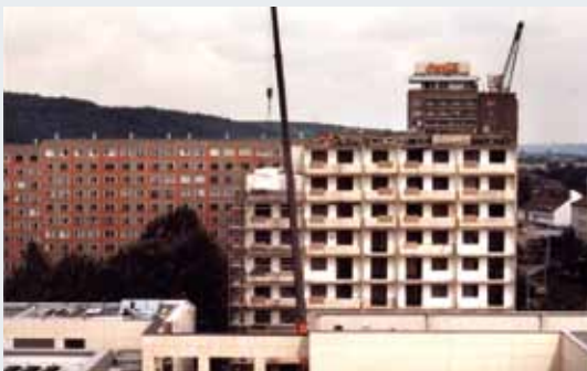
Abbruch Breitscheidstraße 1, März 1998
