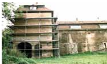
Sicherung des ehemaligen Beamtenhauses der Schlossanlage Osterstein
