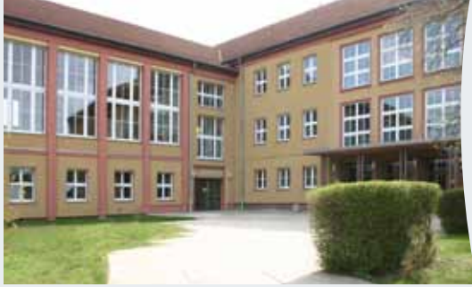
Karl-Theodor-Liebe-Gymnasium, Trebnitzer Straße 18
