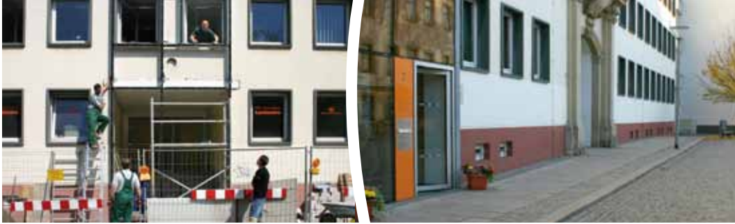
Umbau des Eingangsbereiches mit neuem Kundenzentrum am Unternehmenssitz Johannisplatz 2, 2005
