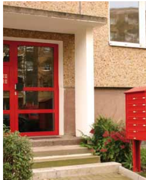
Erneuerung Hauseingänge Bieblach-Ost
