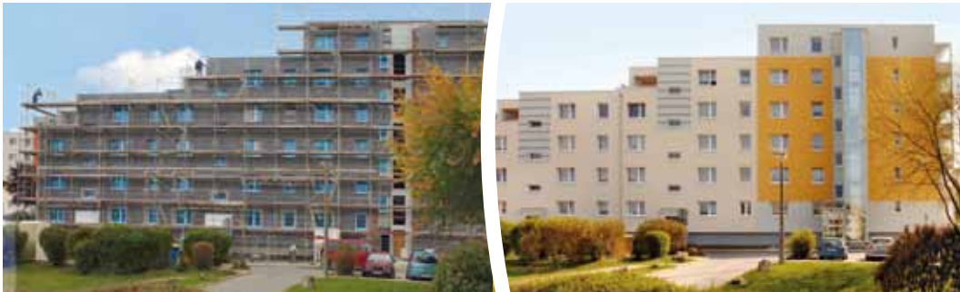
Teilabbruch, Segmentrückbau und Komplexmodernisierung Rudelsburgstraße 10-14
