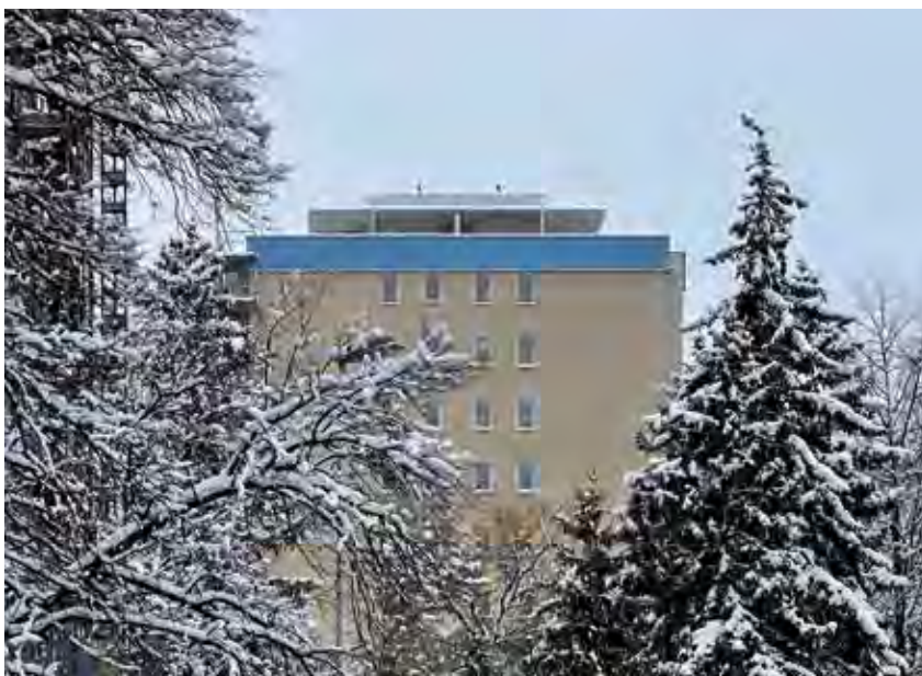
Blick zur Attika und Dachterrasse der Johannes-R.-Becher-Straße 2
