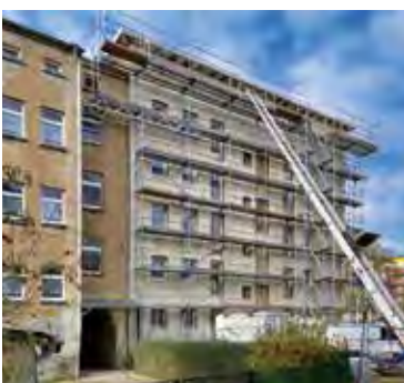
Die Schülerstraße 1 wird von der GWB »Elstertal« zur Zeit aufwändig saniert und in Stand gesetzt.
