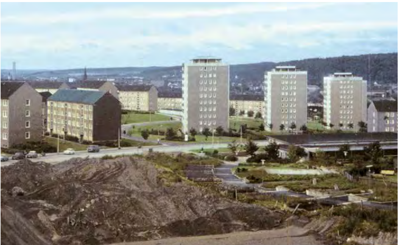
Blick über die Baugrube »Grüne Mulde« zu den Punkthochhäusern Johannes-R.-Becher-Straße 4, 8 und 12, 1970
