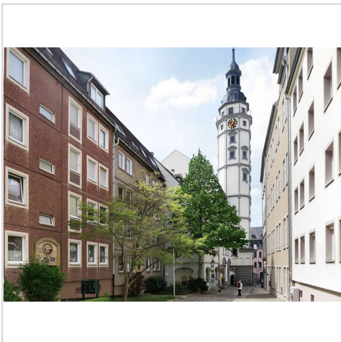
Schuhgasse vor der Sanierung
