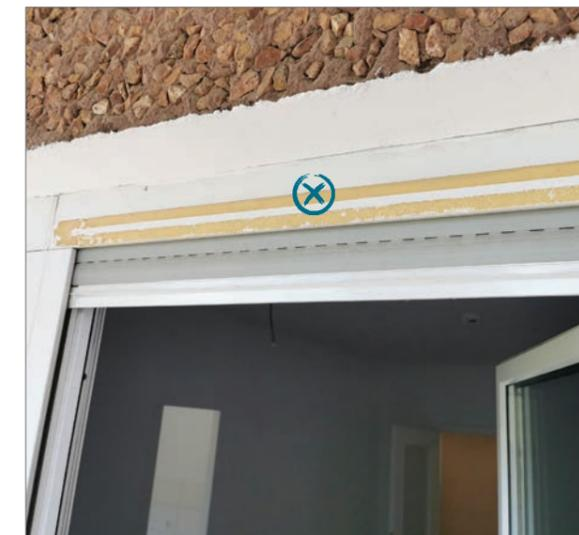
Bohrlöcher in den Fensterbauteilen führen zu Beschädigung der Fenster. Bitte benutzen Sie **Klemmbevestigungen** für die Fensterflügel und **vermeiden Sie Bohrlöcher**.
