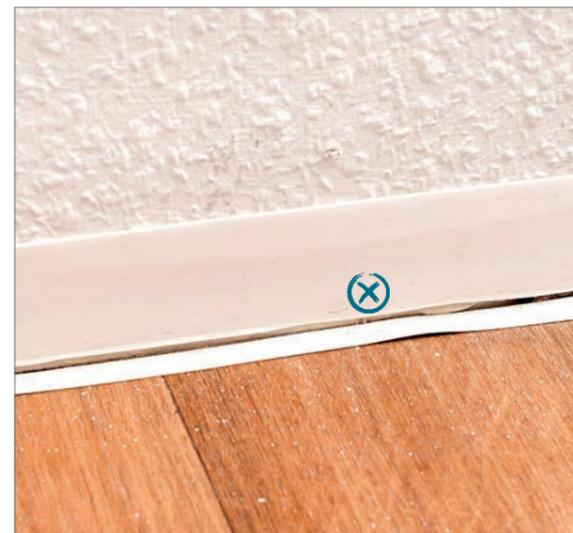
Achten Sie beim Ausbau von Teppichen und Laminat darauf, **keine Beschädigungen** an **Sockelleisten** oder **Heizungskanälen** zu verursachen. Auf dem Foto ersichtlich ist eine zerschnittene Fußbodenleiste mit Weichsockel aufgrund unsachgemäßen Gebrauchs eines Cuttermessers bei Ausbau von Teppichboden.
