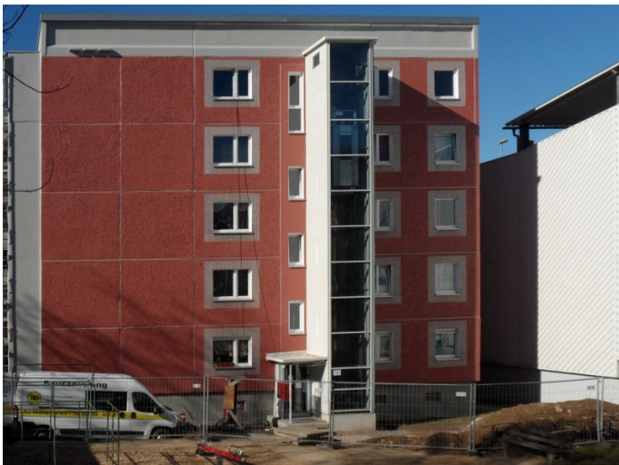
Gebäude bei der Sanierung
