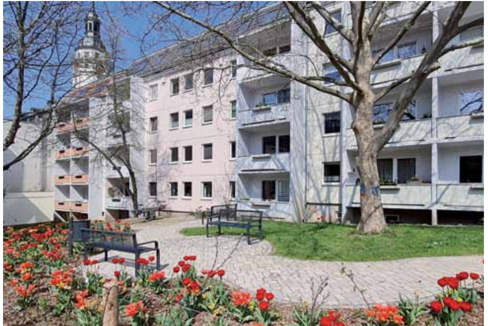
Neugestalteter Aufenthaltsbereich der Wohngebäude Schuhgasse 4–8
