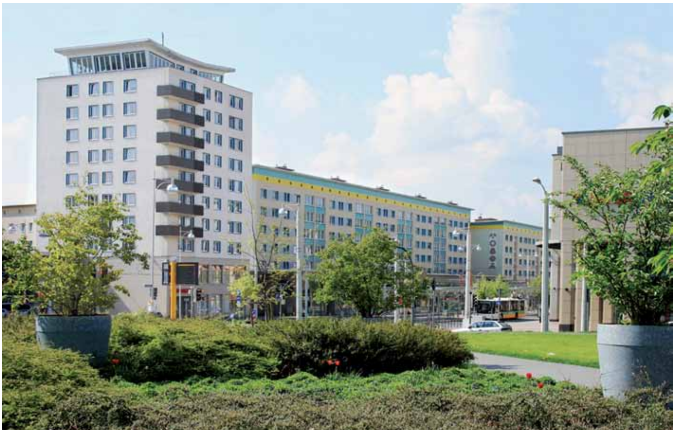
Blick zu den Wohngebäuden der GWB »Elstertal« in der Heinrichstraße, 2014
